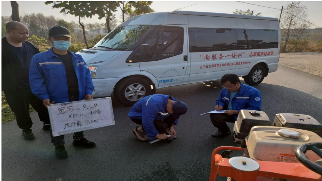
图片 4-4：农村公路路面质量帮扶检测
