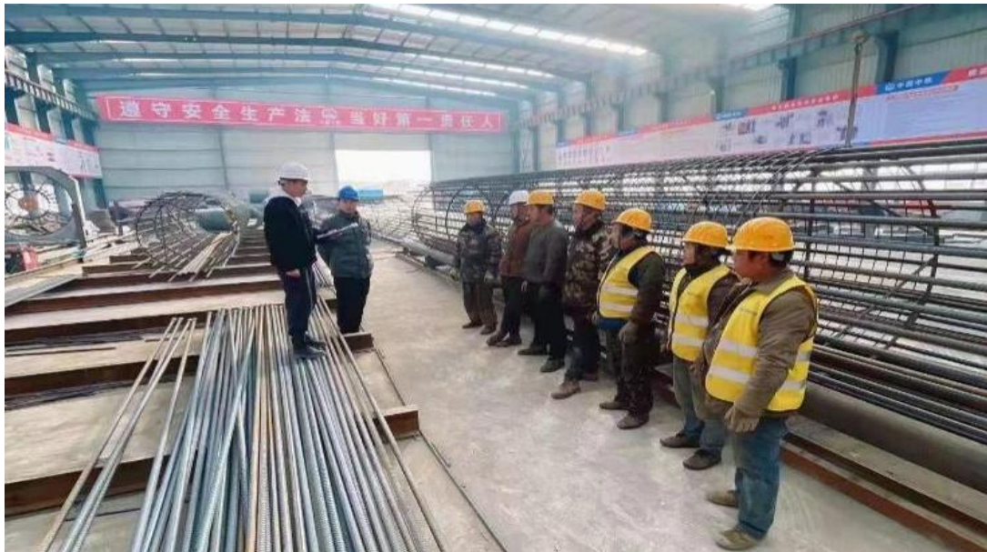
图片 4-1：本桓高速技术人员对钢筋加工班组进行桩基钢筋笼加工技术交底
