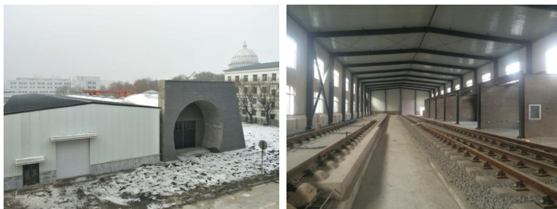
图 4-3 建设中的隧道工程和轨道工程实训中心
