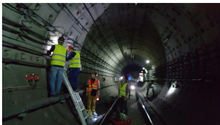
图 7-1 公路工程质量检测中心承担的沈阳南北二干线监控项目施工现场
